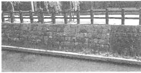
s 石材を用いて整備された護岸
