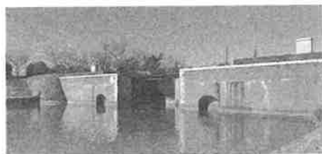
1921 年に完成した水害対策施設
